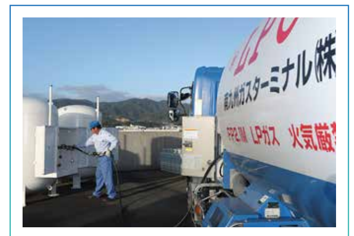
バルク貯槽へ充填
